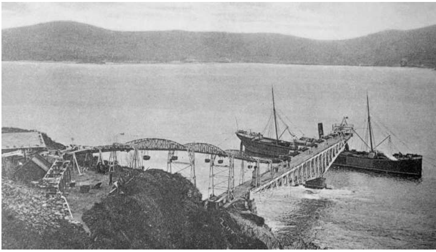
Figura 12: Cargadero de A Insua: viga en voladizo con la vertedera sobre la escotilla de un barco de vapor (autor P. Hernández Sampelayo, 1935).
