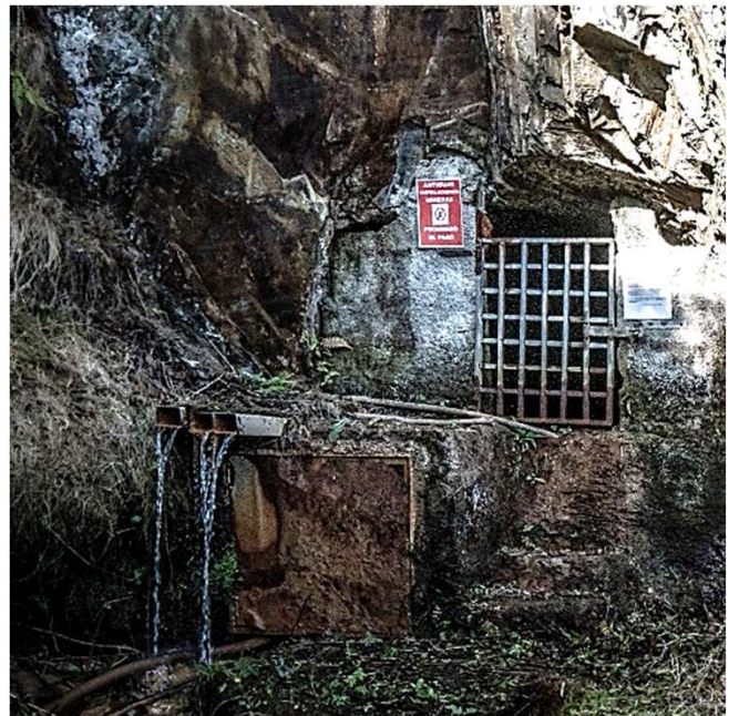
Figura 4: La Galería Federico drena el agua subterránea proveniente de galerías superiores.
